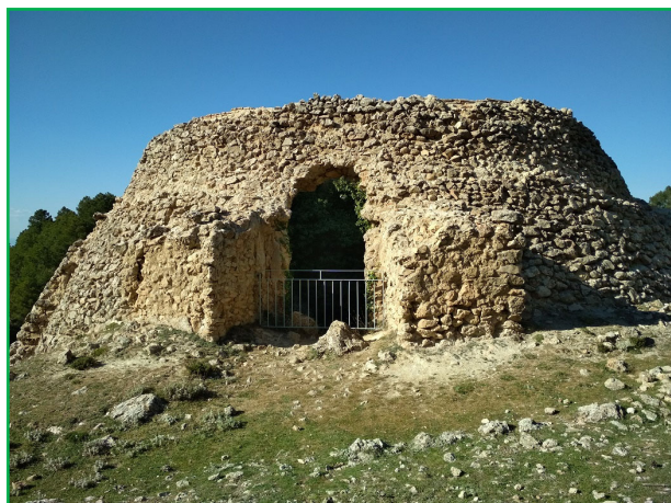
Pozo de la Nieve nº 11
