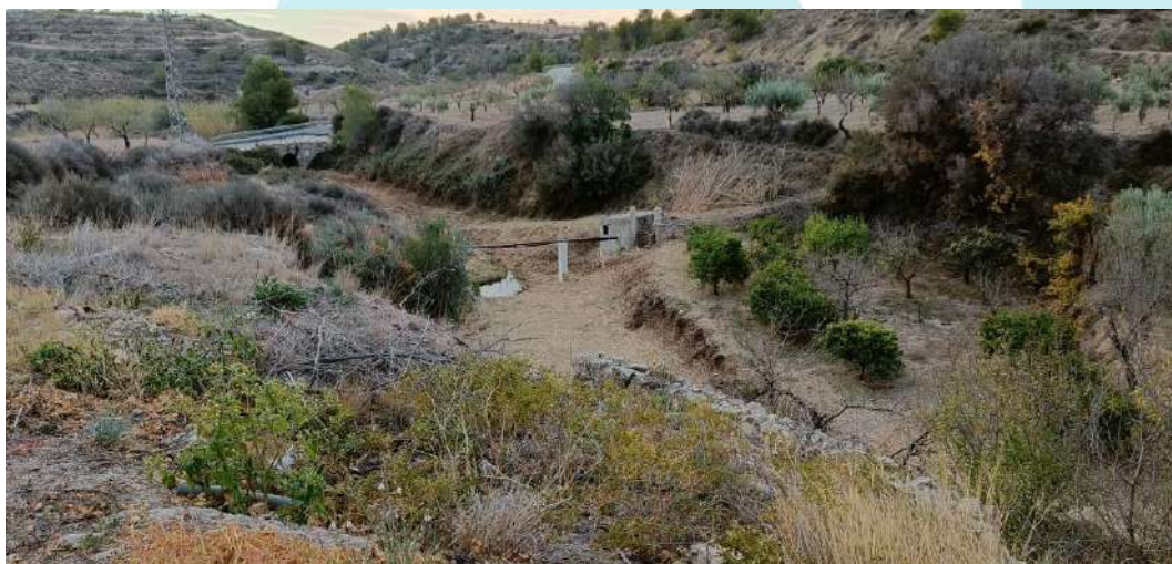
Eliminación de cañaveral en Zona de actuación 2
