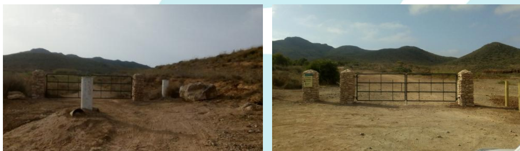
Imágenes 16 y 17. Cancelas instaladas en las Ratoneras.
