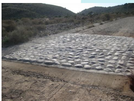
Imagen 20. Resalto instalado en camino
