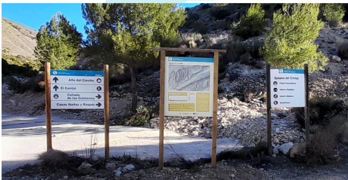
Fotos: Obras de instalación de señales PR Sierra del Carche - 2022
