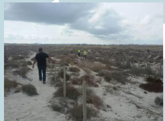
Operarios retirando vallado periférico
