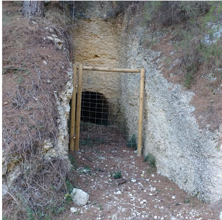
Fig. 5. Cerramiento de la Mina de Algeciras con un vallado compatible con la entrada y salida de quirópteros. Estas especies vuelan sin problemas por encima de la puerta de madera.
