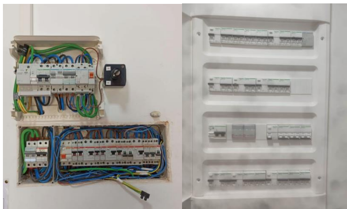
Imágenes 38 y 39. Cuadro eléctrico antes y después de su sustitución.
