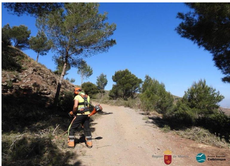
Imagen 4. Apertura de faja auxiliar en la carretera RM-F42, en el Llano del Beal.
