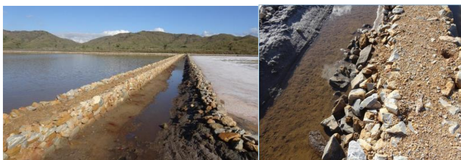
Imágenes 14 y 15. Mota a demoler y algunos derrumbes de esta.
