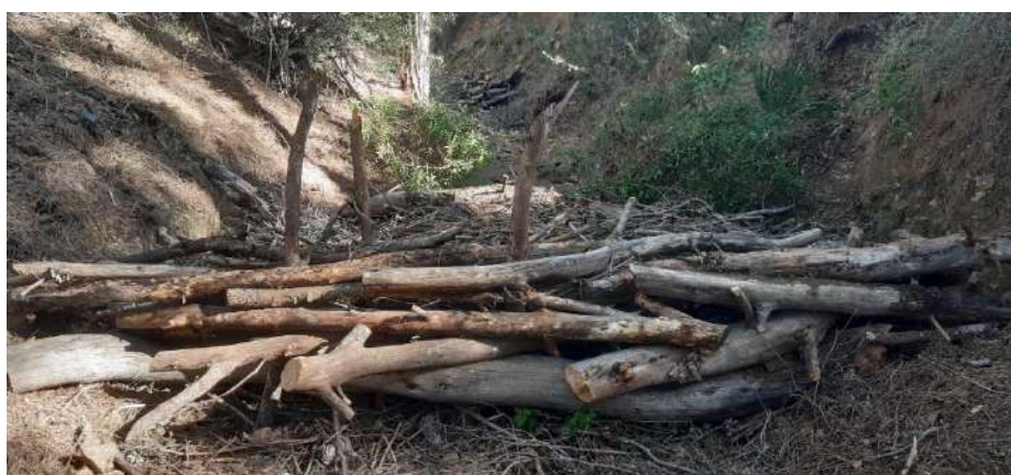
Imagen 44. Construcción de una faja en el área de las actuaciones.
