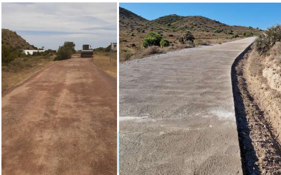
Imágenes 33 y 34. Adecuación de camino Cobaticas- Jordana y tramo hormigonado.
