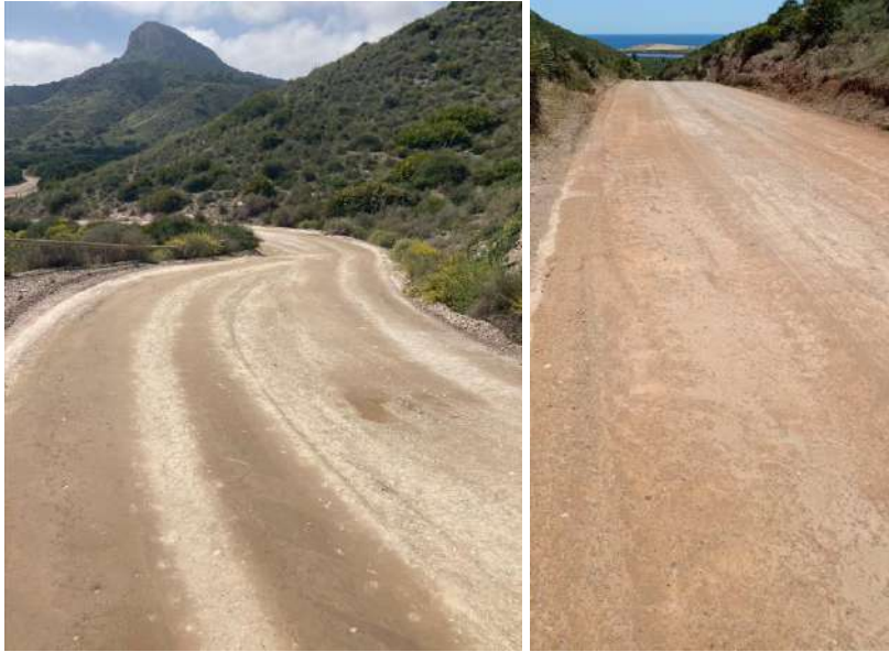
Imágenes 35 y 36. Estabilizado de los caminos del área de playas.
