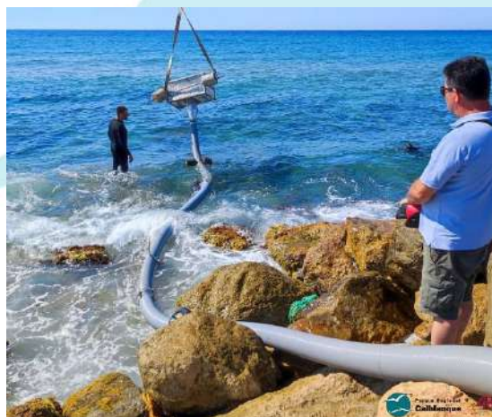
Imagen 17. Instalación del sistema de abastecimiento de agua de mar a las Salinas del Rasall
