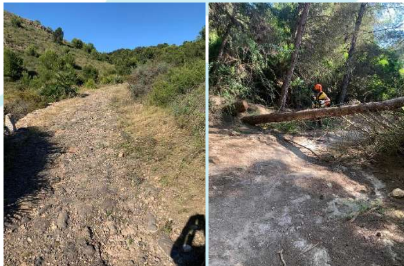
Imágenes 7 y 8. Trabajos selvícolas desarrollados en la Calzada Romana
