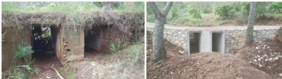
Imágenes 45, 46, 47 y 48. Estado de la pista forestal antes y después de la ejecución de los trabajos.
