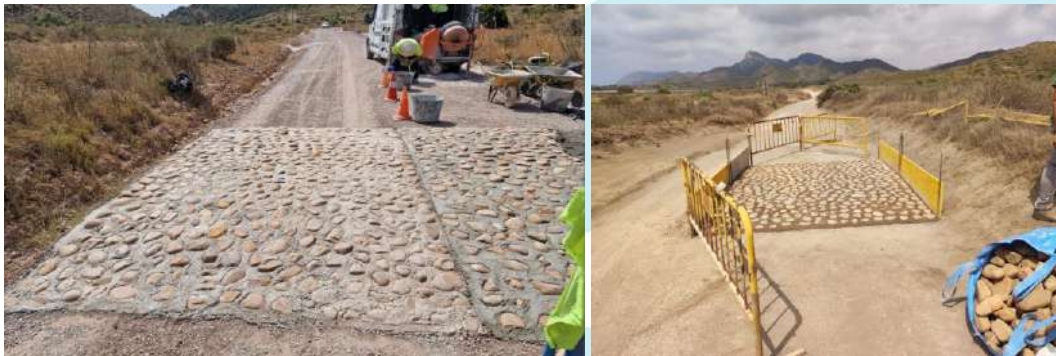
Imágenes 37 y 38. Instalación de reductores de velocidad en los caminos del área de playas.
