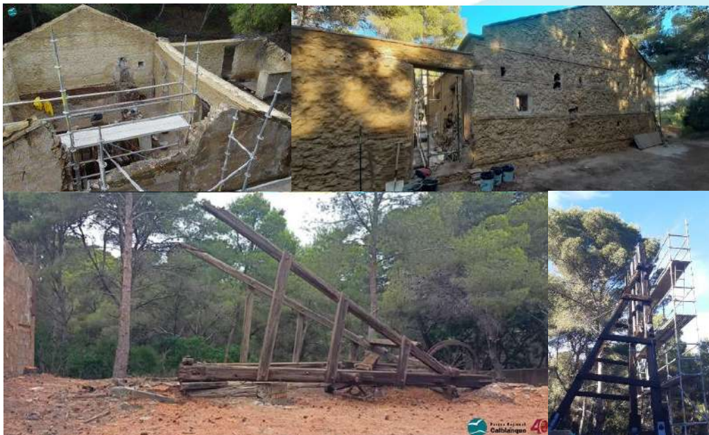
Imagen 24. Imágenes del proceso de restauración de la casa de máquinas y del castillete de madera de la mina Santo Tomás.
