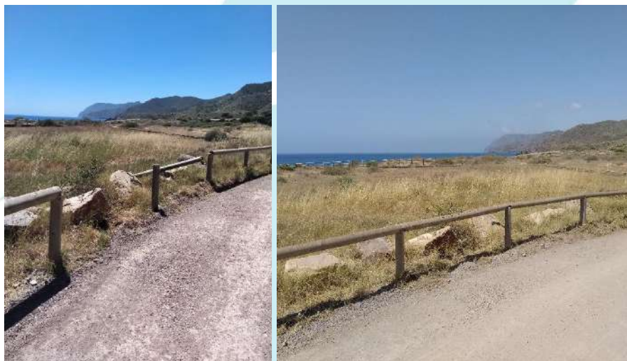
Imágenes 2 y 3. Labores de mantenimiento de infraestructuras del Parque Regional.
