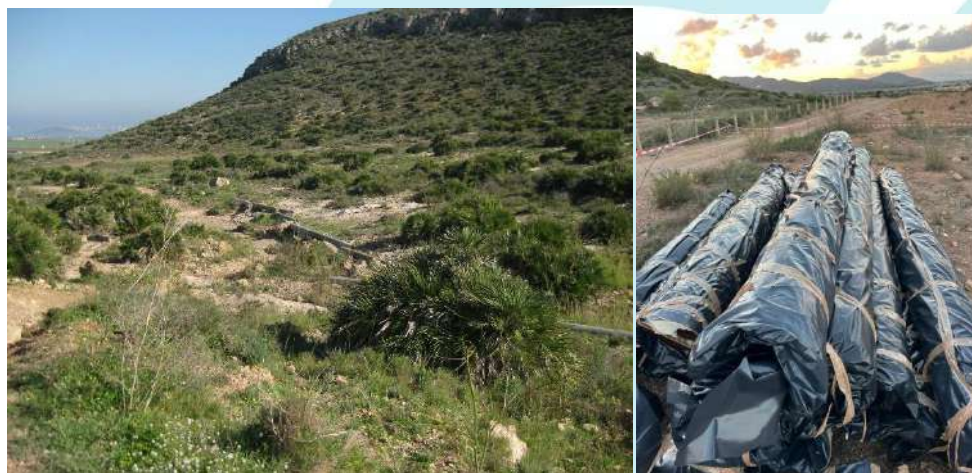
Imagen 26. Retirada de la tubería de fibrocemento de la Vía Pecuaria.
