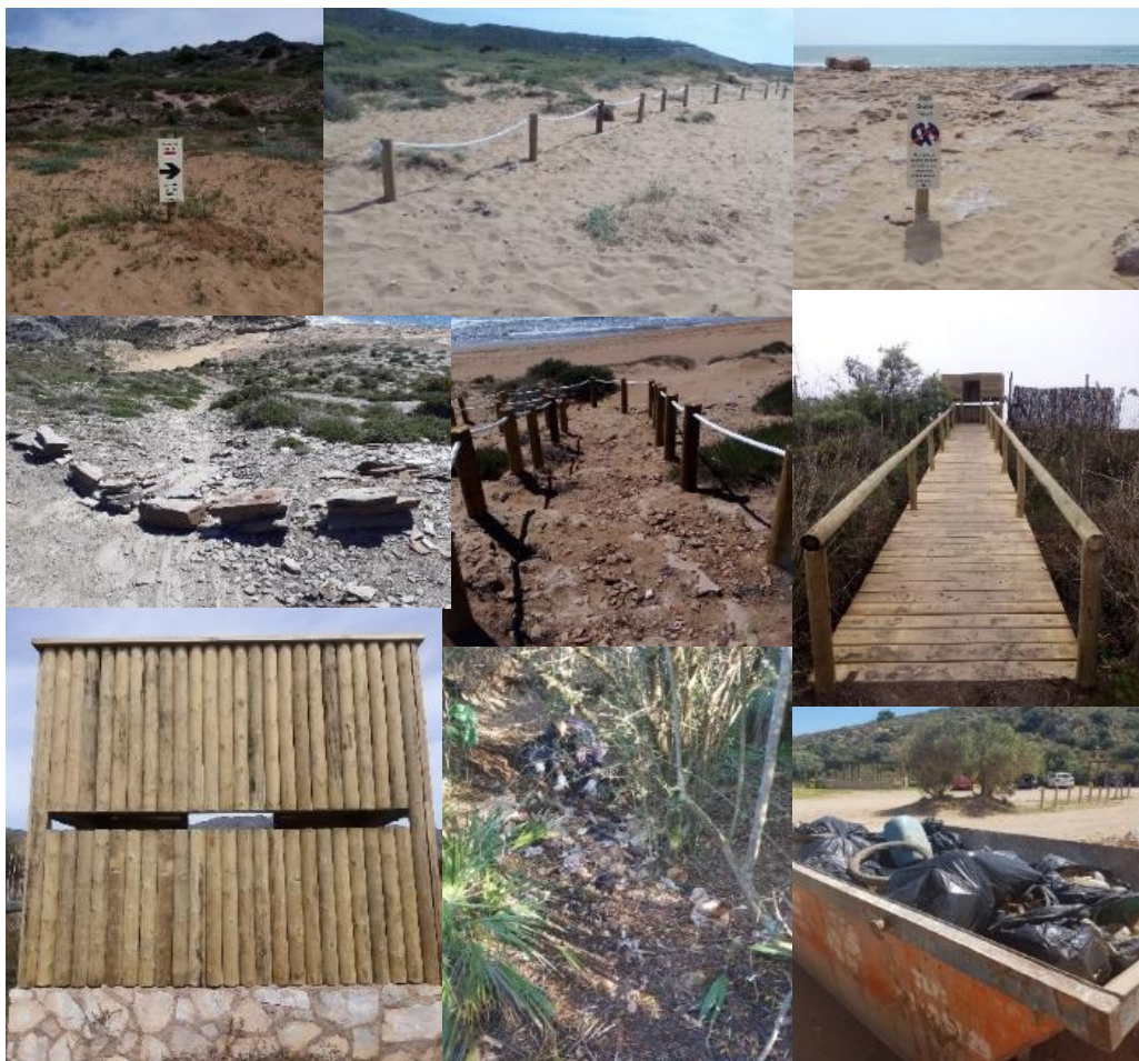
Imagen 32. Actuaciones de mejora de infraestructuras de uso público en el sector este
