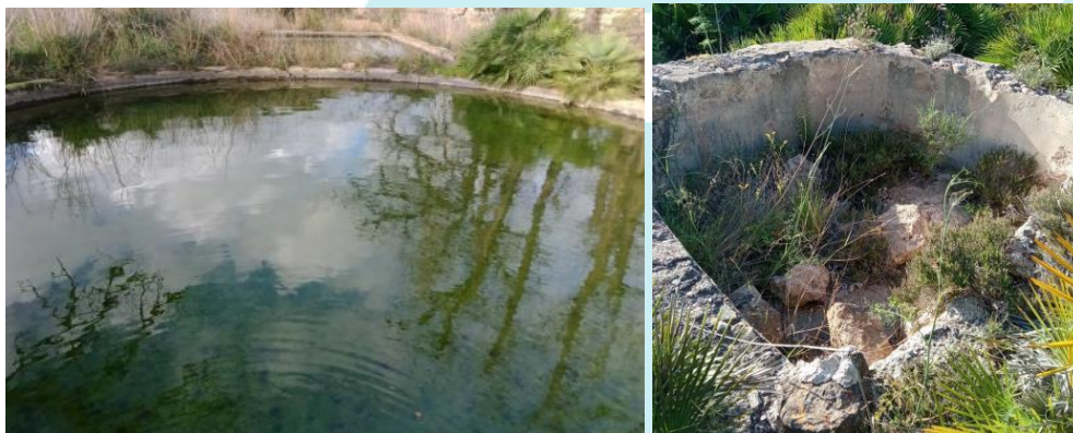
Imagen 20 y 21. Identificación de cuerpo de agua en uso y en desuso
