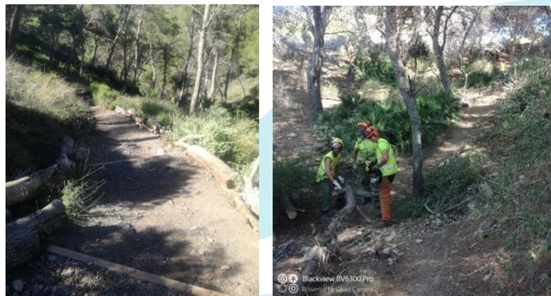
Imagen 6 y 7. Colocación de trozas en las sendas de Cenizas y La Chapa
