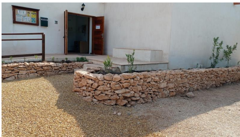
Imagen 44. Imágenes del murete de piedra y adecuación de explanada de acceso
