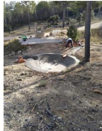
Labores de acondicionamiento y restauración de uno de los aljibes de la Sierra del Carche
