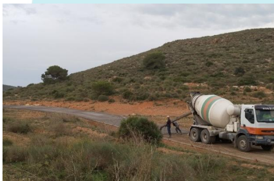
Imagen 27. Hormigonado de un tramo del camino de acceso al Parque
