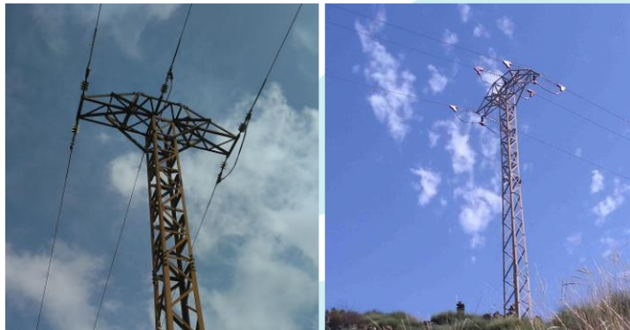
Imágenes 5 y 6. Imágenes de uno de los apoyos corregidos, antes y después de la intervención.
