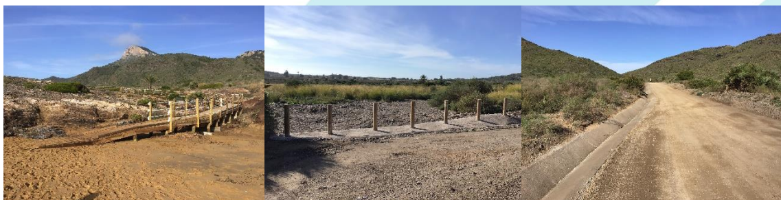
Imagen 29. Estado de las infraestructuras de uso público una vez ejecutadas las obras.
