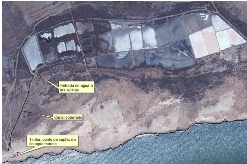
Imagen 7. Entrada de agua desde el mar a las Salinas del Rasall.
