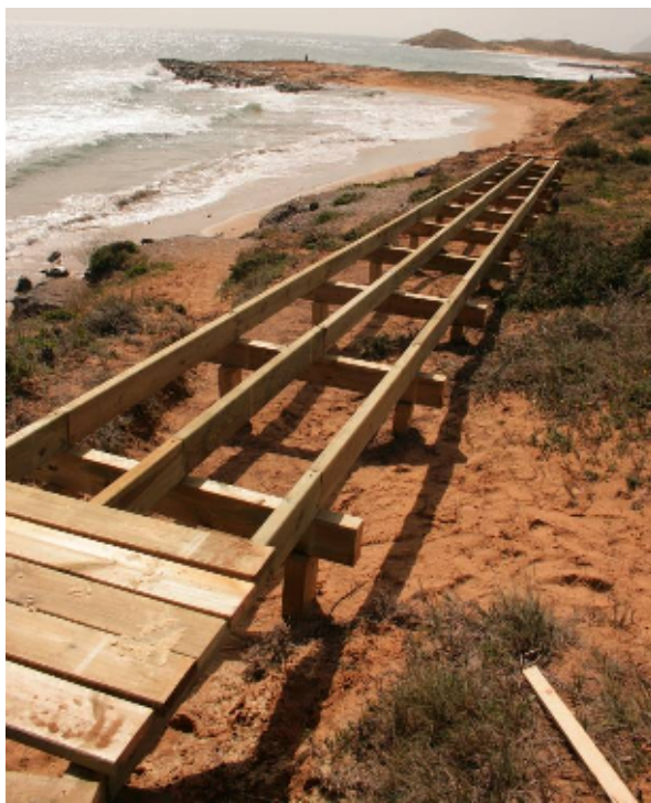
Construcción de pasarela accesible para personas de movilidad reducida a la Cala Magre.
