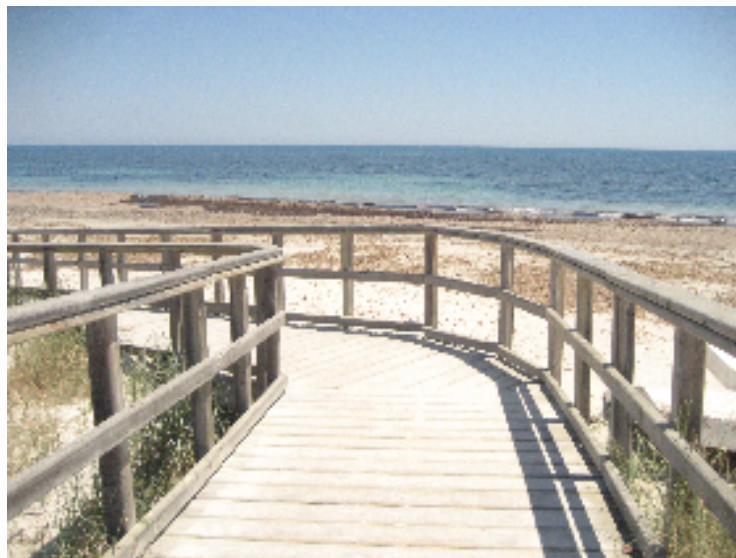
Pasarela de acceso a la playa "Torre Derribada".
