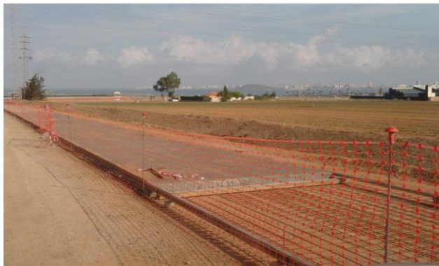
Foto 3. Obras de hormigonado en el acceso principal al Parque
