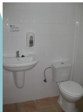
Foto 7. Nuevo aseo en el Punto de Información
