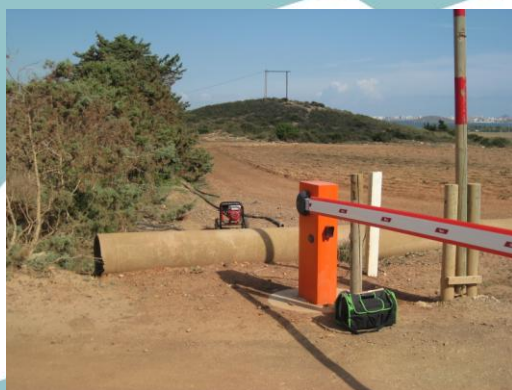
Foto 4. Instalación de barrera electrónica
