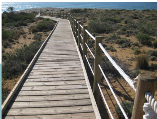
Foto 1. Instalación de bolardos con cuerdas
