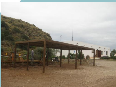
Foto 6. Delimitación de área de estacionamiento exterior
