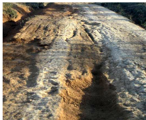
Arreglo de caminos en mal estado
