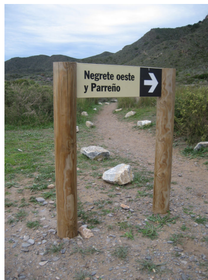
Arreglo de senderos en mal estado e instalación de cartelería
