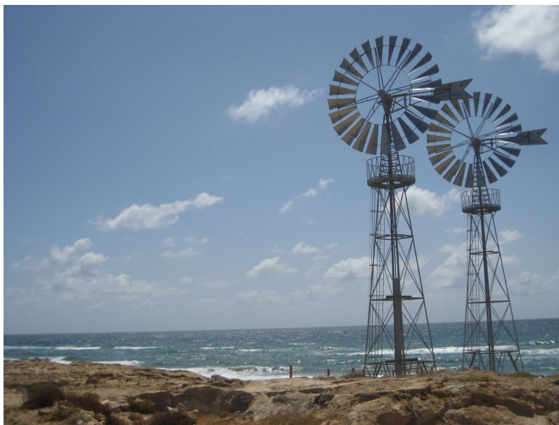
Aerobombas de las salinas del Rasall
