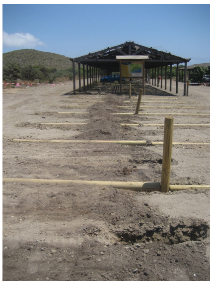
Delimitación de plazas en zona de estacionamiento
