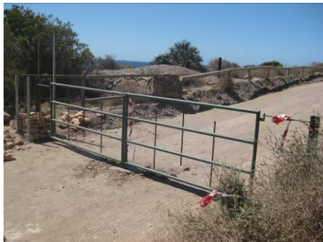
Foto 26 Imagen de la instalación de una de las cancelas
