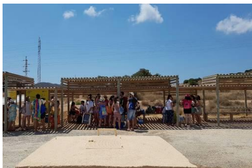
Foto 27 Sombraje del aparcamiento disuasorio
