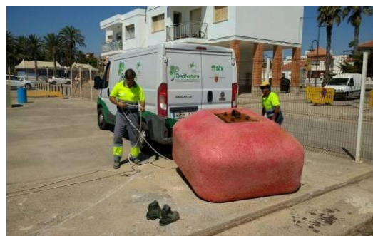
Foto 5 Posterior retirada a un gestor de residuos adecuado.
