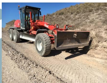
Foto 20 Imagen durante la mejora de la red viaria.
