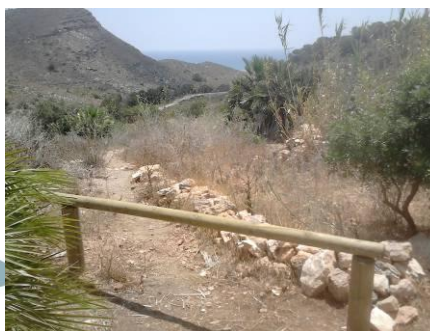
Foto 23 Imagen de una talanquera instalada
