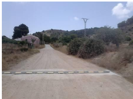
Foto 22 Imagen de uno de los reductores instalados
