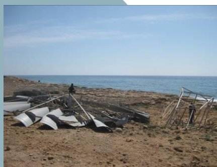
Foto 18 Desmontaje de la molineta
