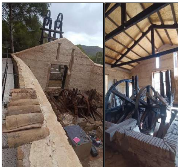
Imágenes 11 y 12. Sala de máquinas restaurada sin cubierta y sala de máquinas con cubierta completa tras las obras de restauración.
