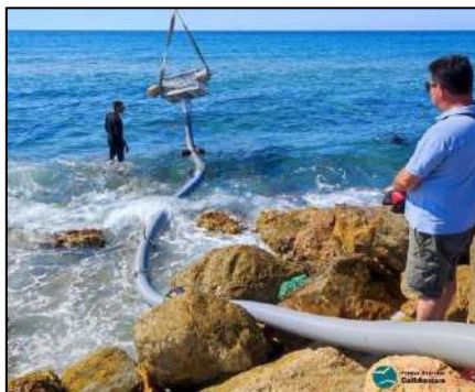
Imagen 8. Instalación del sistema de abastecimiento de agua de mar a las Salinas del Rasall.
