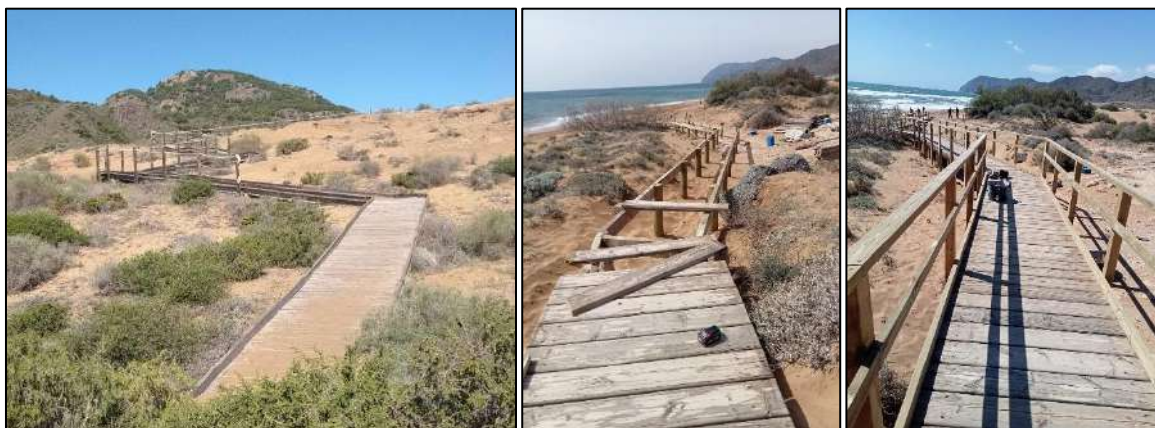
Imágenes 17, 18 y 19. Pasarela desmontada, montaje de la nueva pasarela y nueva pasarela terminada.
