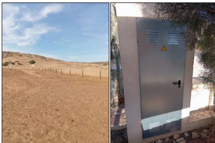
Imágenes 20 y 21. Bolardos trasladados y nueva puerta del contador.
