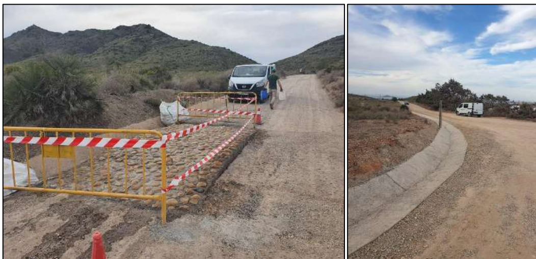
Imágenes 15 y 16. Construcción de nuevo resalto y camino acondicionado con zahorra y nueva cuneta de hormigón.
