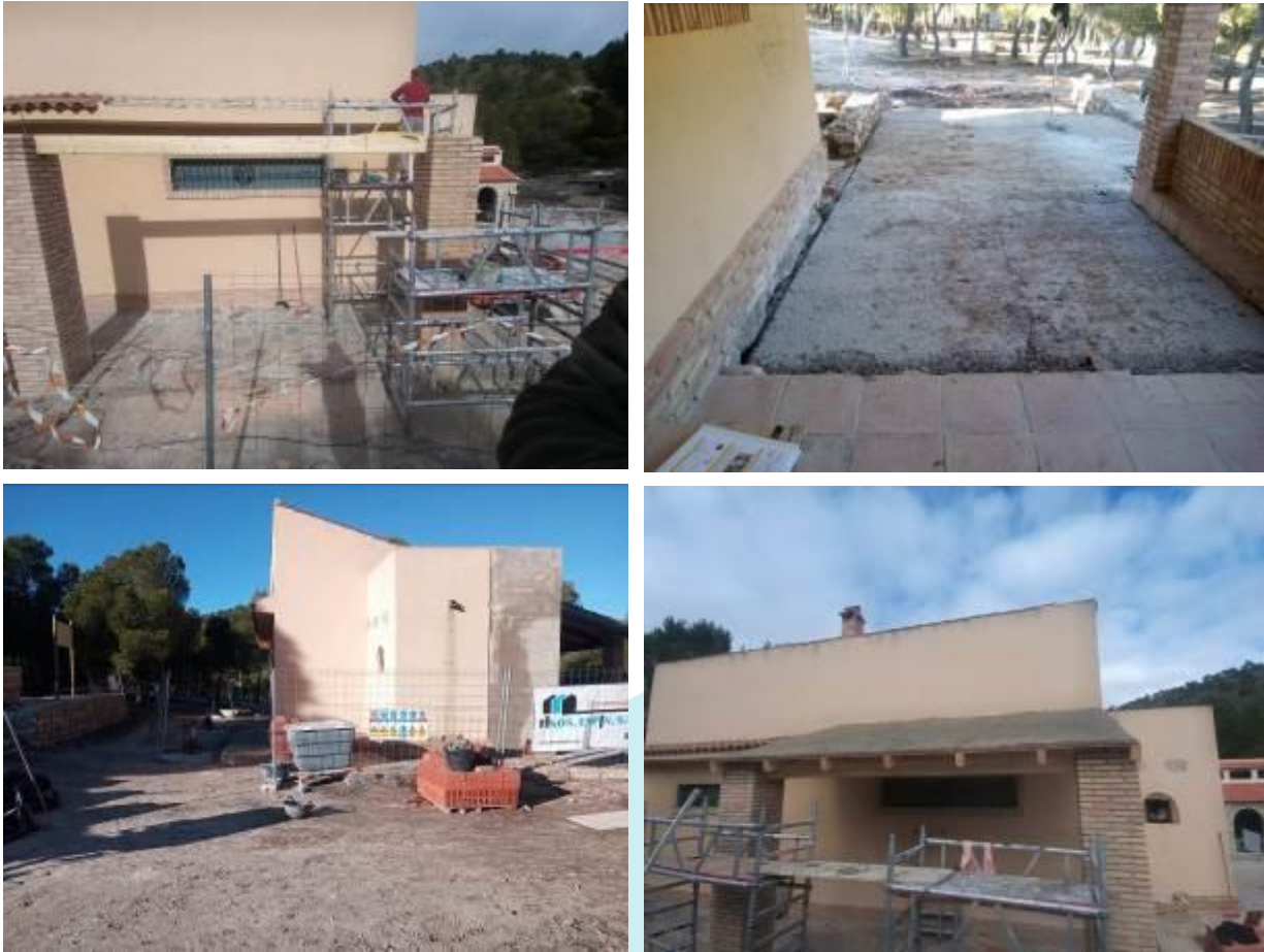
Figura 4: Inicio de las obras de rehabilitación del Punto de Información de Fuente la Higuera en área recreativa del mismo nombre, en el PR Sierra de la Pila.
