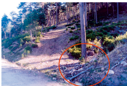
Fig 30. La limpieza de cuneta y otras, zonas de desagües se hará al final de los trabajos.
