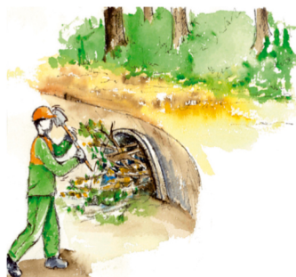
Fig 30. La limpieza de cuneta y otras, zonas de desagües se hará al final de los trabajos.
