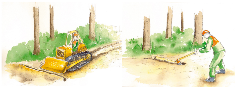
Figura 22. Ejecución de cortes de agua al finalizar los trabajos.
