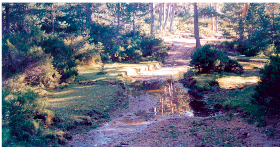
Fig 7. Invasión de la red de drenaje superficial por una pista o vía forestal.
