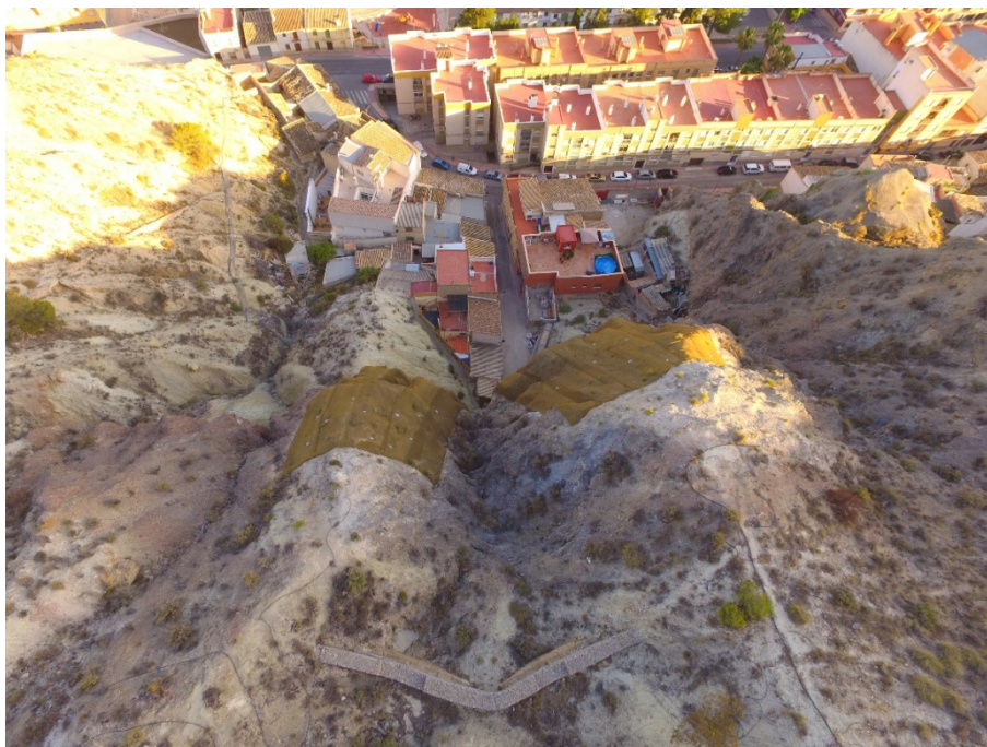
FOTO 9. Malla de estabilización en el MUP - 41
