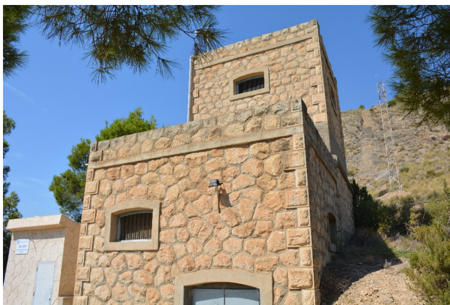
FOTO 11. Edificio Mancomunidad visitado mediante trabajo de campo
