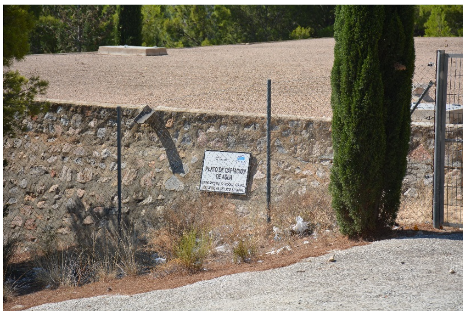
FOTO 9. Depósito captación de aguas
