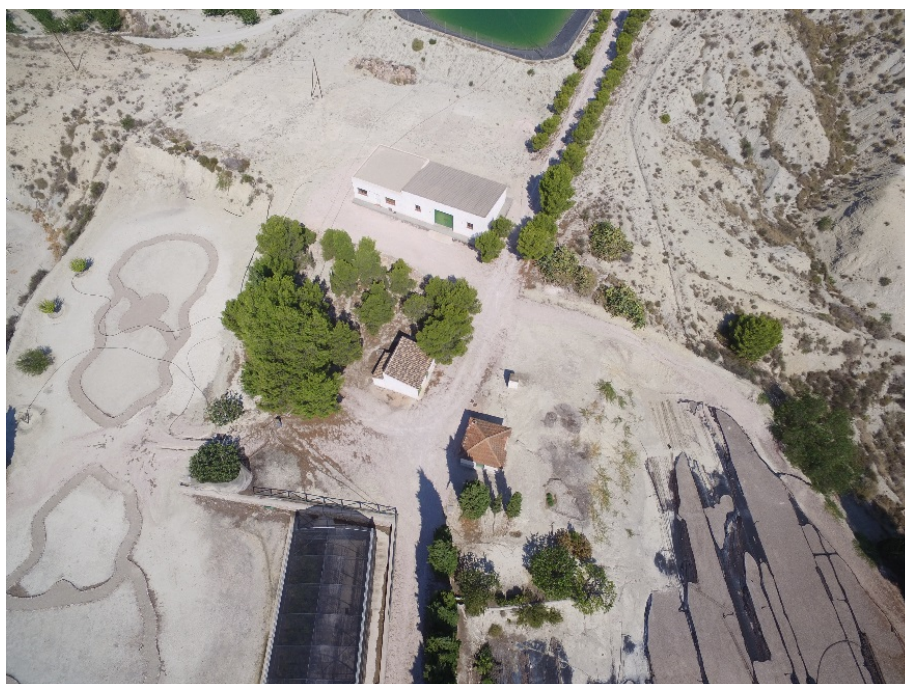
FOTO 7. Invernadero, caseta y nave (vista aérea)
