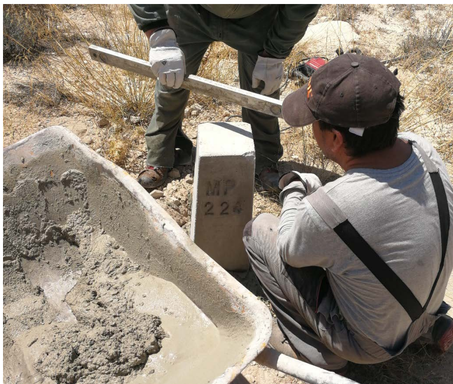
FOTO 13. Ejemplo de colocación de nuevo mojón
