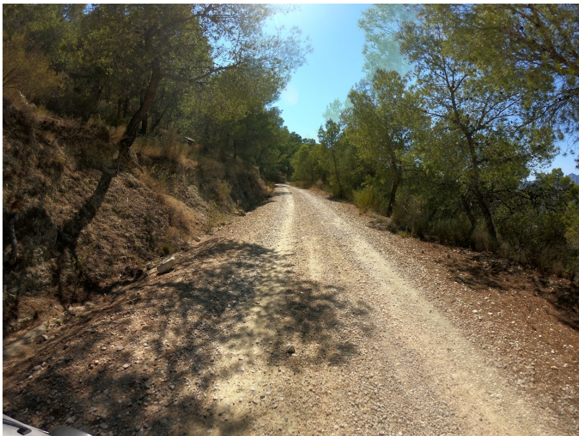
FOTO 8. Pista principal de Nivel1 "OJ-M0065-N1-1"
