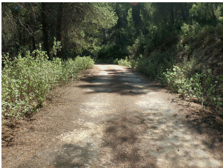
FOTO 8. Imagen de la pista de nivel 1 CE-M0032-N1-1
