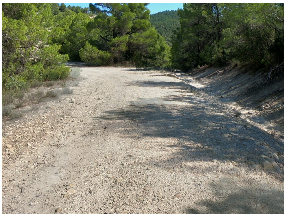
FOTO 9. Imagen de la pista de nivel 2 CE-M0032-N2-2
