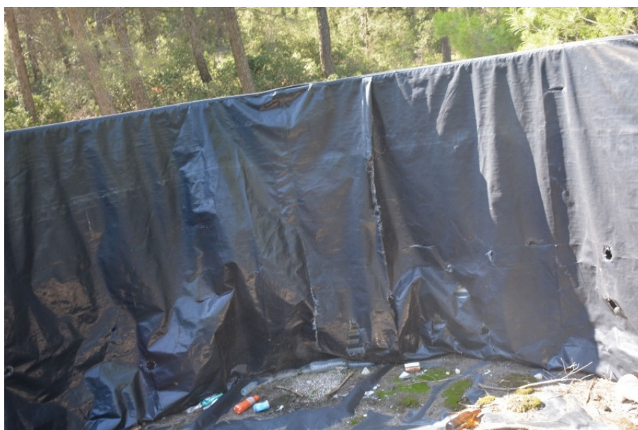
FOTO 12. Interior de depósito
