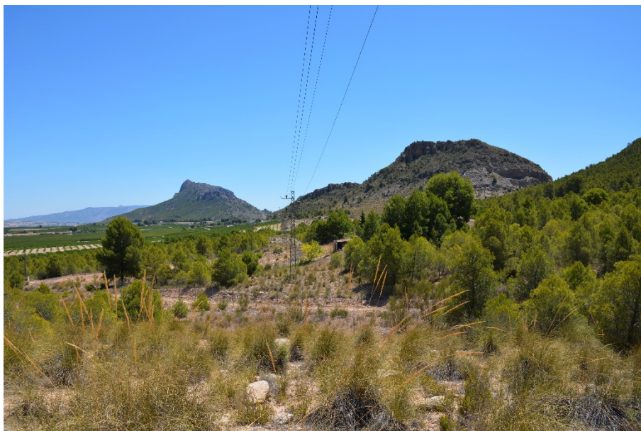
FOTO 8. Faja cortafuegos línea eléctrica “CLE-03”
