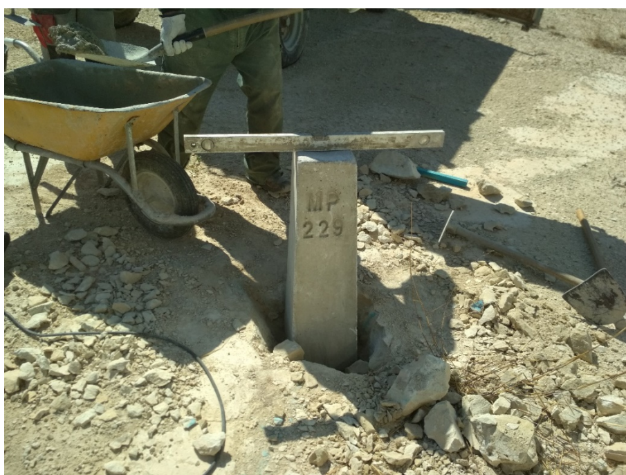
FOTO 16. Ejemplo de colocación de nuevo mojón
