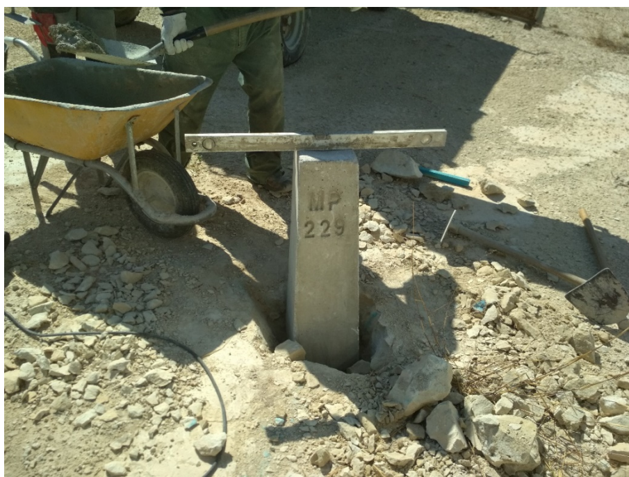
FOTO 13. Ejemplo de colocación de nuevo mojón
