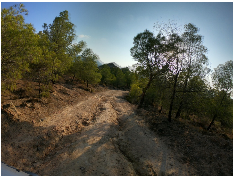
FOTO 11. Tramo de la pista "CI-M0147-N1-1" con necesidad de mejora en el drenaje
