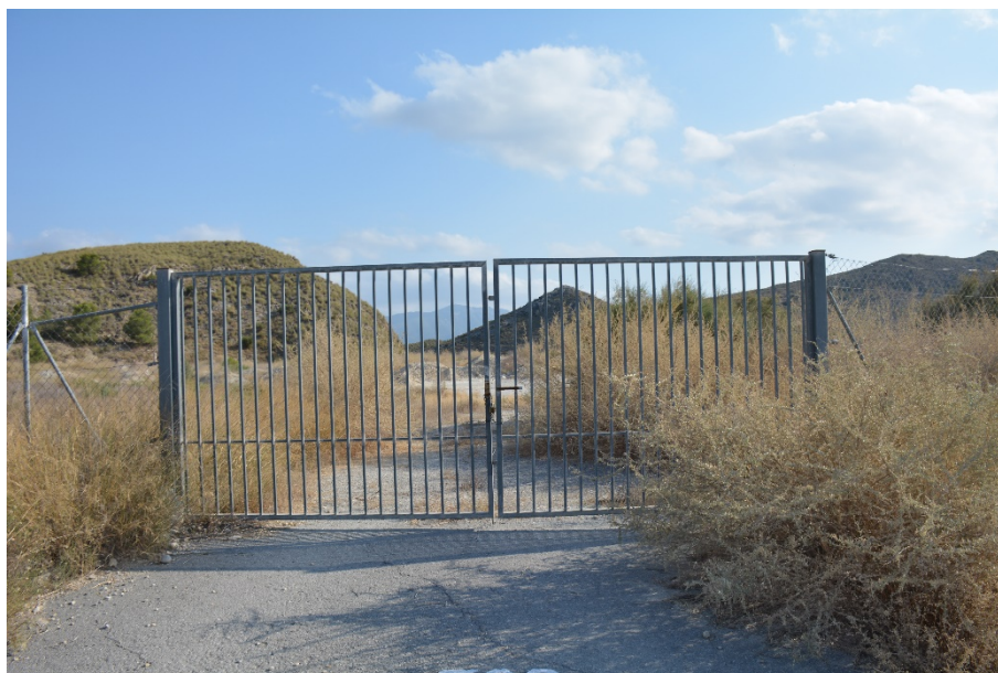
FOTO 10. Antiguo vertedero de escombros
