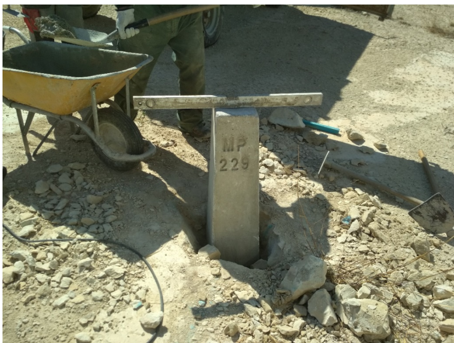
FOTO 12. Ejemplo de colocación de nuevo mojón
