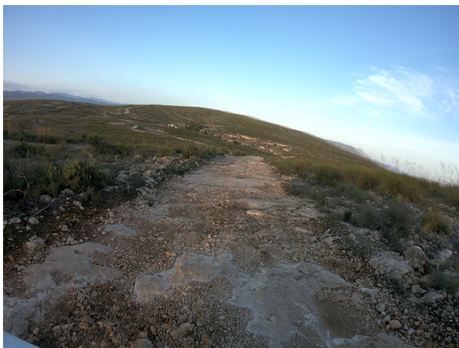
FOTO 7. Camino de Nivel 3 "CI-M0139-N3-1"
