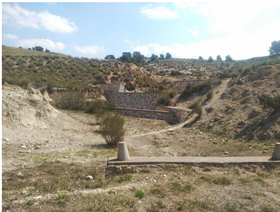
FOTO 10. Dique localizado en el MUP - 138
