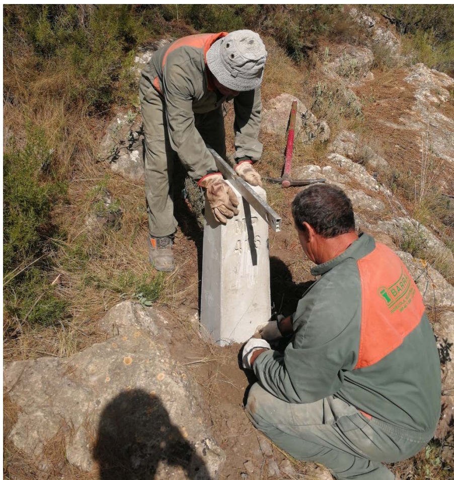
FOTO 11. Ejemplo de colocación de nuevo mojón
