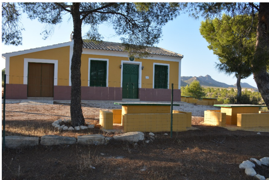
FOTO 15. Casa Forestal reacondicionada
