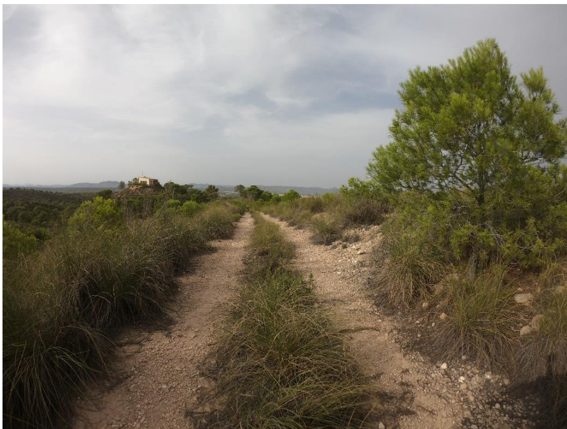
FOTO 11. Camino de nivel 3 "CI-M0048-N3-1"
