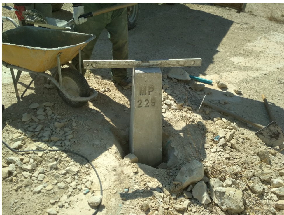
FOTO 13. Ejemplo de colocación de nuevo mojón
