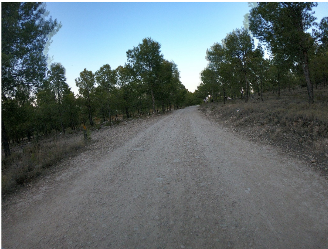
FOTO 10. Vista de faja auxiliar FA-01 con planificación de actuaciones de mejora
