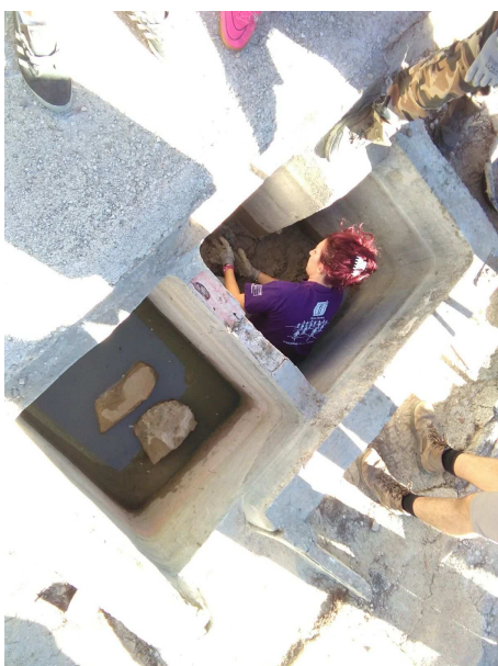
Foto 3: Voluntaria haciendo trabajos de reconstrucción de rampa
