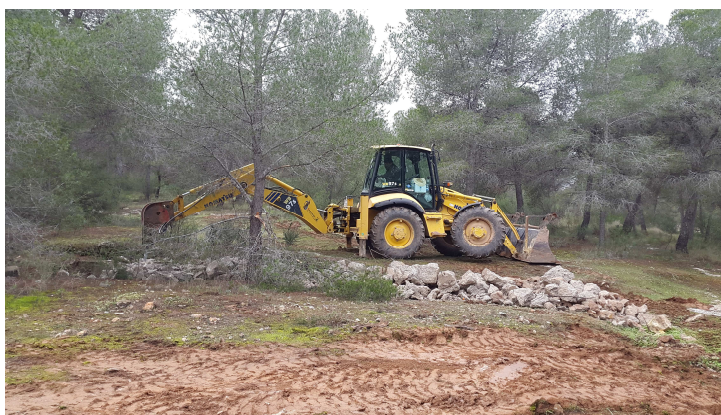
Foto 3: Maquinaria picando una correa de hormigón
