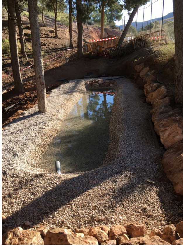
Foto 4: Humedal finalizado a falta de plantación
