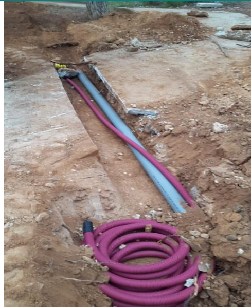
Foto 4: Apertura de zanja para la colocación de las conducciones
