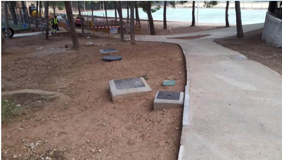
Foto 3: Zona de pre-tratamiento terminada
