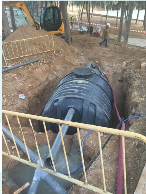
Foto 1: Colocación depósito
