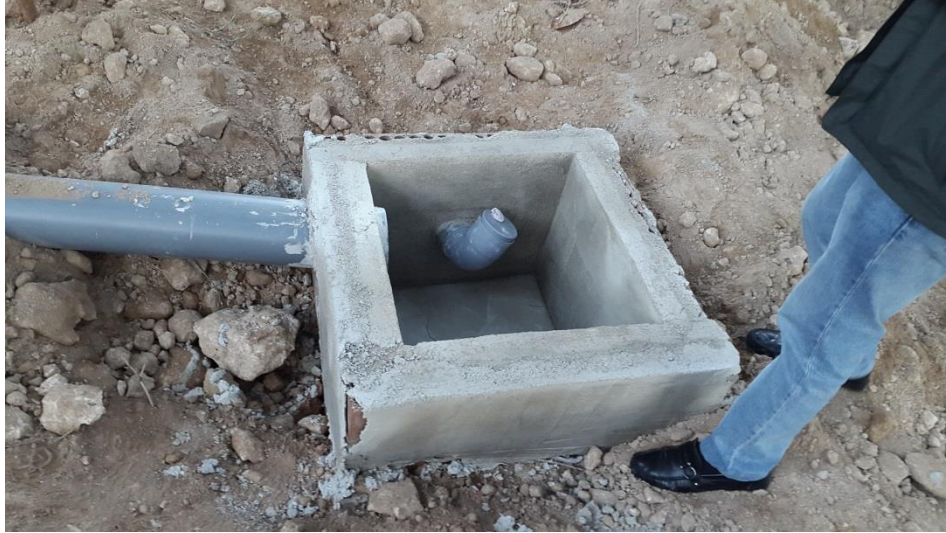
Foto 2: Construcción de arqueta
