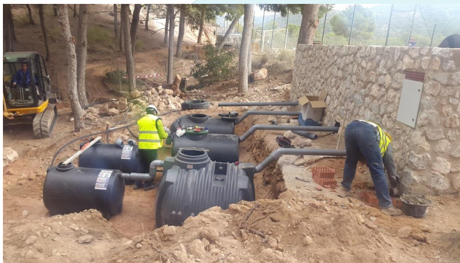
Foto 5: Instalación sistema de depuración en la fase de "tratamiento"
