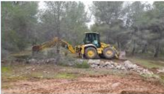
Foto 3: Maquinaria picando una correa de hormigón
