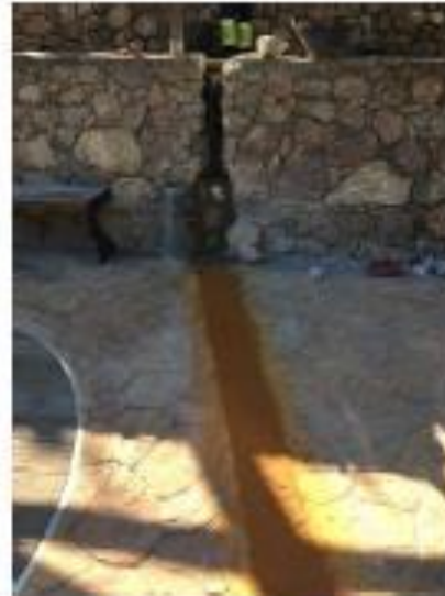
Detalle de la tubería y acabado simulando el relieve del suelo del CRFS
