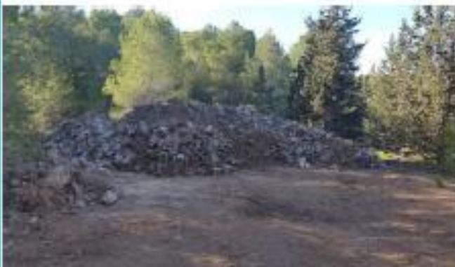
Foto 5: Acumulación en montones de los restos de hormigón
