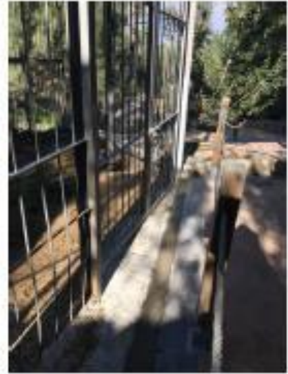
Imágenes de la zanja hormigonada por donde discurre la tubería y manguera flexible en la zona de los tanques
