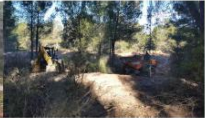
Foto 4: Máquinas retirando restos
