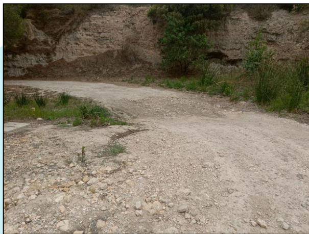
Imágenes del camino de acceso a Fuente La Higuera. A la izquierda, detalle de los derrumbes en la cuneta y a la derecha, zona donde se pretende ejecutar un badén.
