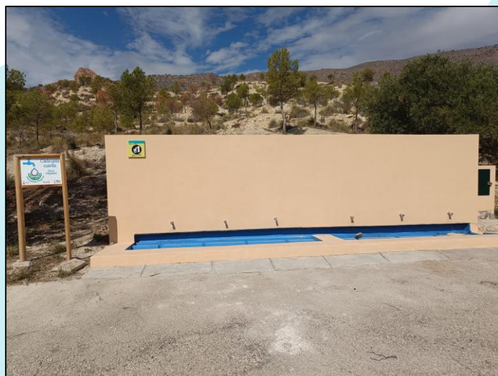
Estado de la Fuente del Javé, antes y después de las actuaciones
