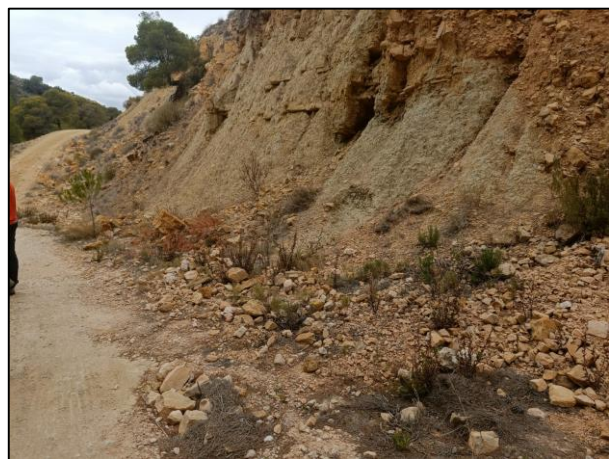
Imágenes del camino de acceso a Fuente La Higuera. A la izquierda, detalle de los derrumbes en la cuneta y a la derecha, zona donde se pretende ejecutar un badén.
