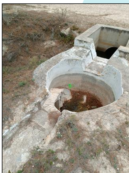
Imagen de los decantadores del aljibe antes y después de las actuaciones
