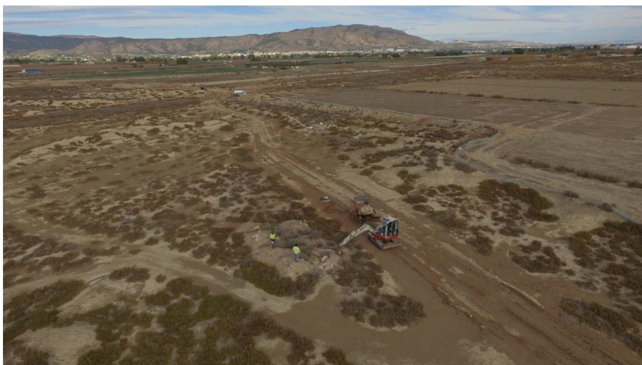
Equipo retirando residuos
