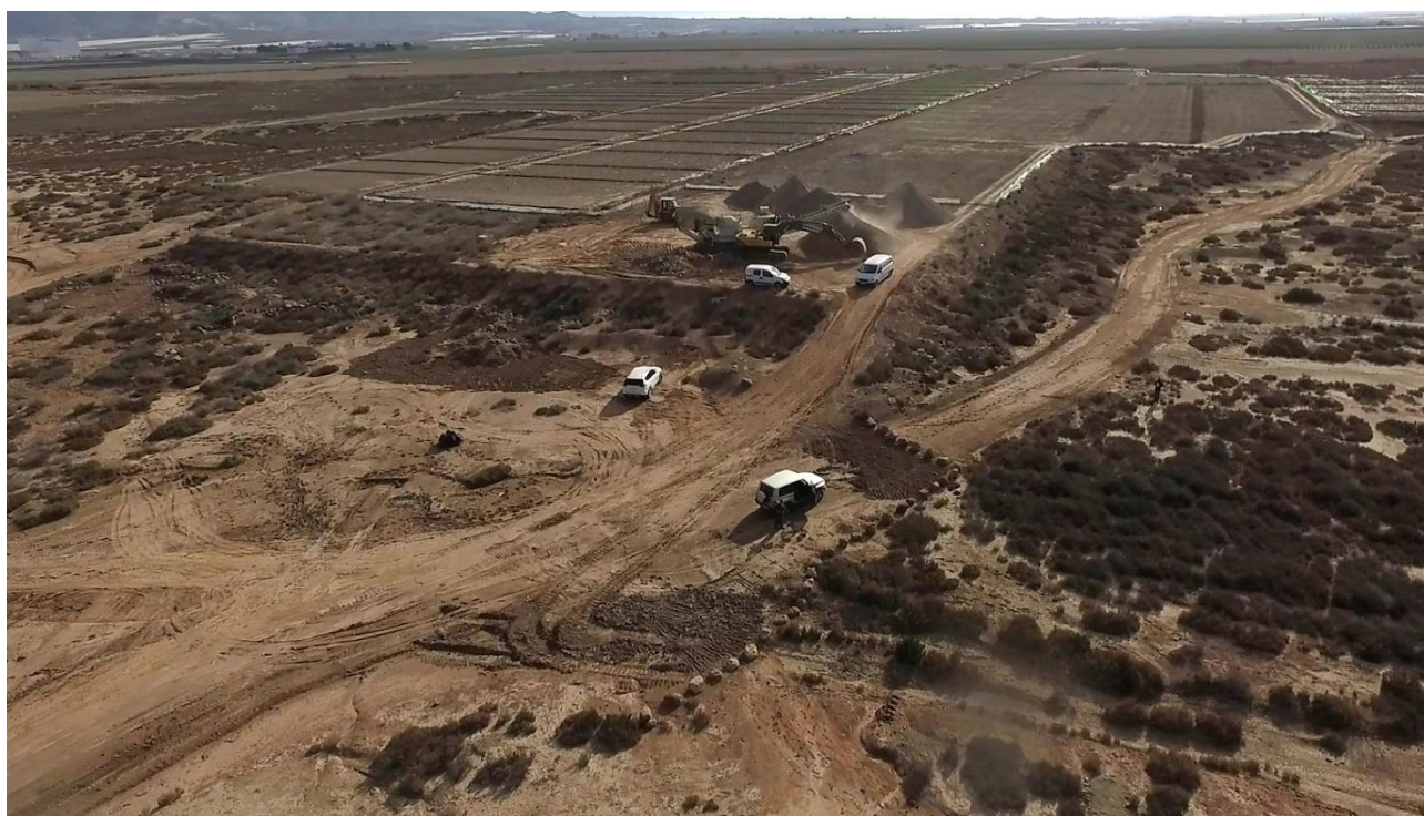
Cierre de accesos con piedras y planta de triturado
