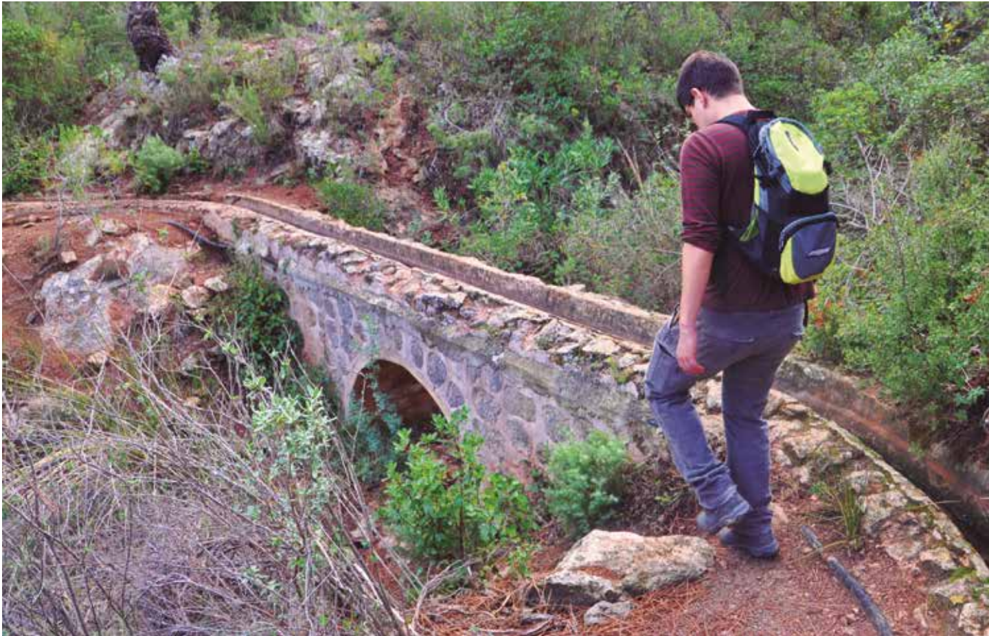
ACUEDUCTO AÉREO PARA SALVAR UNA VAGUADA. CAÑO DE ESPUÑA. LGM.
