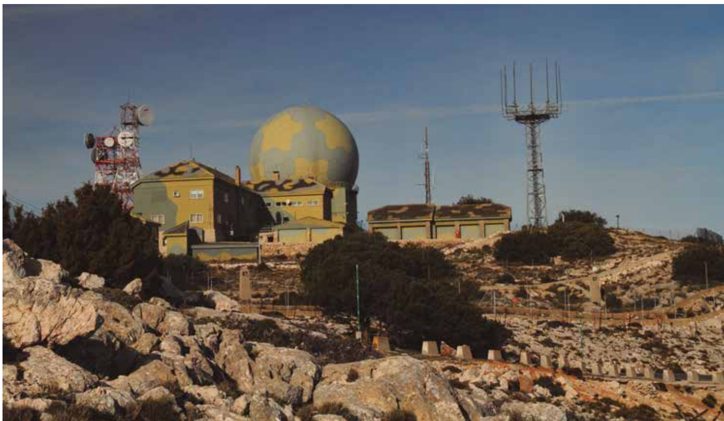
INSTALACIONES Y RADOMO DEL RADAR LANZA. MAG.
