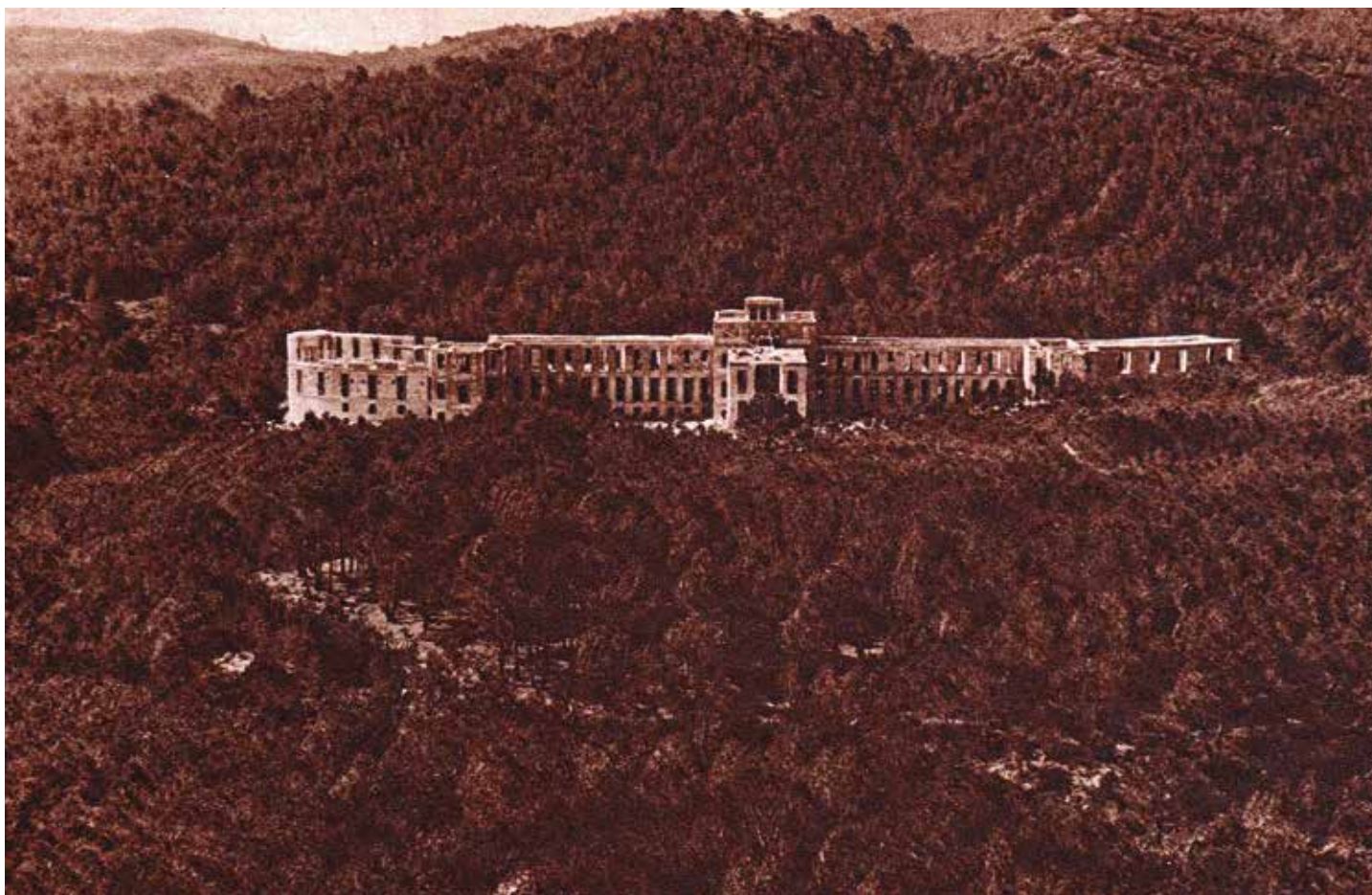
ESTADO DEL SANATORIO HACIA 1927. OBSÉRVESE QUE AÚN NO TIENE LA CUBIERTA. VISTA NORTE. MAG.
