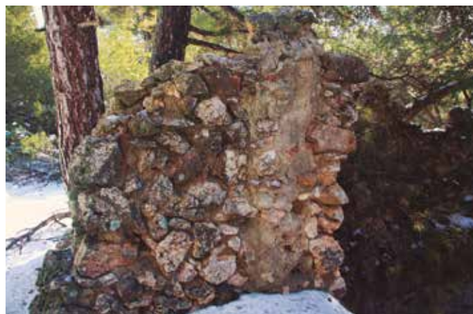
MURO SUPERIOR DEL POZO DE D. ELEUTERIO. AÚN SE APRECIA LA ZONA DONDE ANCLABA EL MARCO DE LA PUERTA. MAG.
