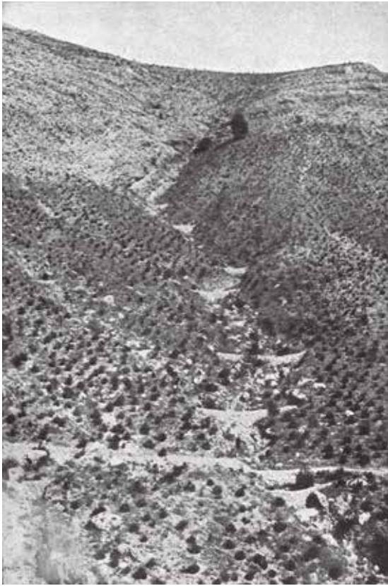
BARRANCO CORREGIDO CON DIQUES DE SECCIÓN TRIANGULAR. OBSÉRVESE CÓMO UNA SENDA PASA POR ENCIMA DE UNO DE ELLOS. AÑO 1911. ARCHIVO DGMN-CARM.
