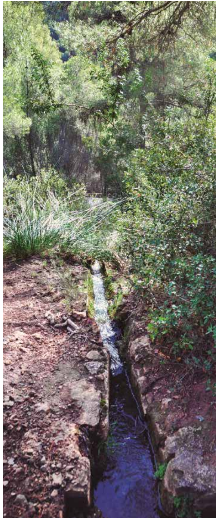
EL CAÑO DE ESPUÑA EN SU TRAMO ALTO. LGM.
