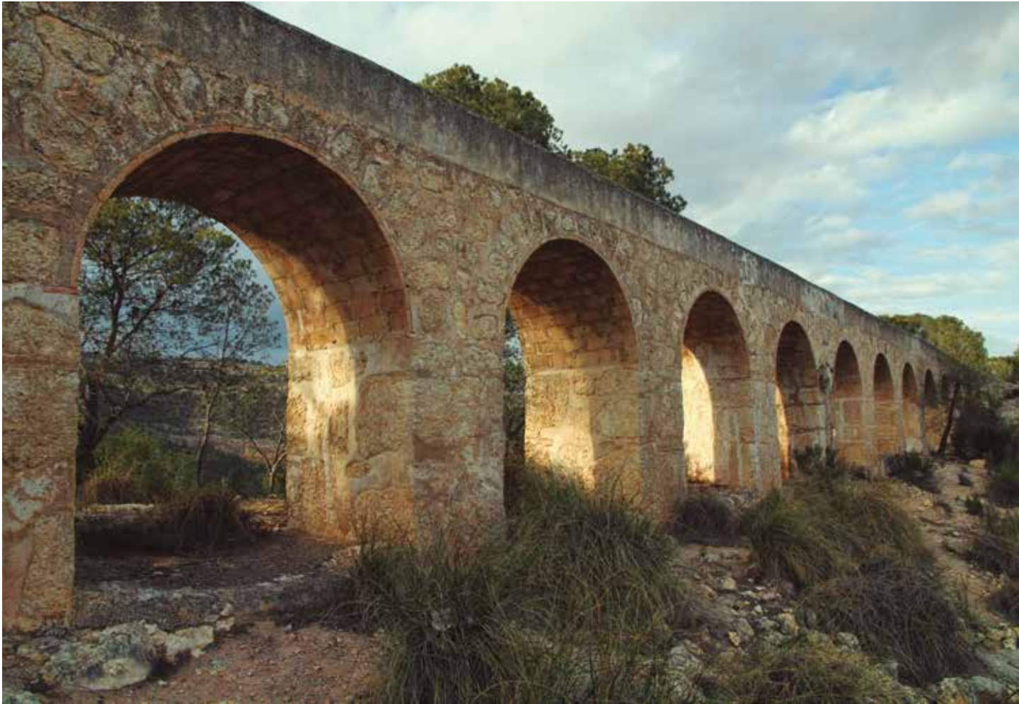
EL CAÑO ESPUÑA TAMBIÉN ES UNA IMPRESIONANTE OBRA HIDRÁULICA. ACUEDUCTO DE CARMONA. MAG.
