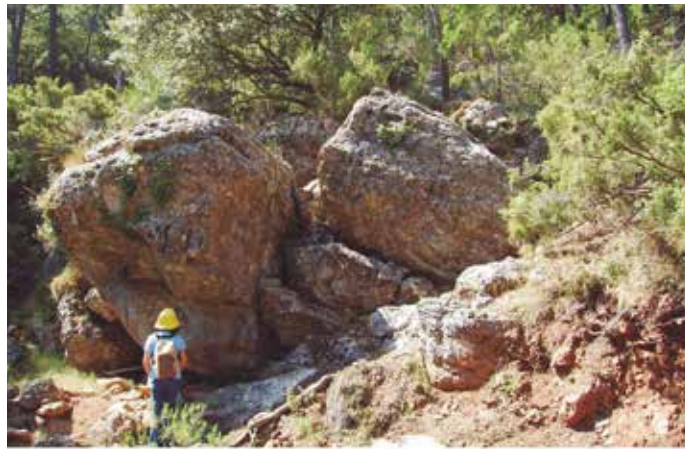
Bloques caídos junto al sendero
