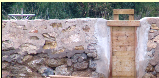
Reparación de compuertas en Marchamalo
