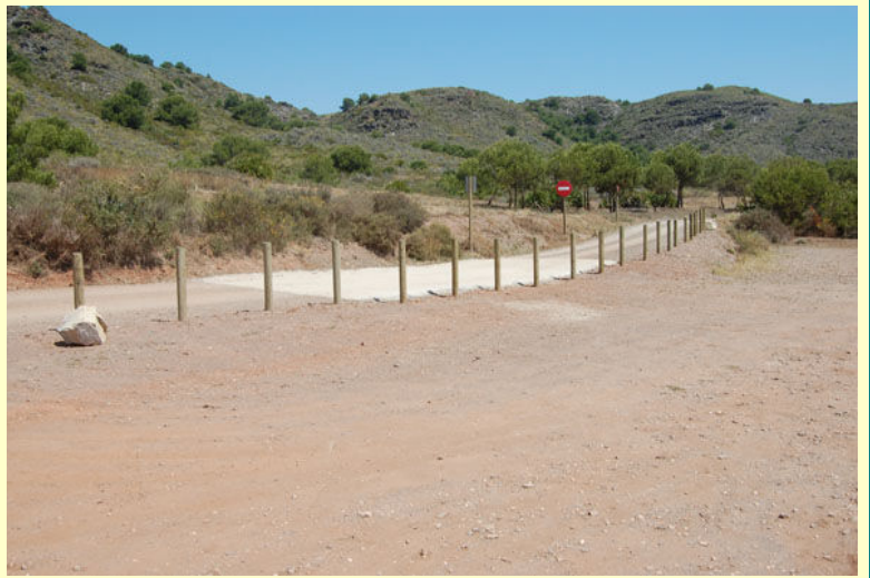
Instalación de bolardo
