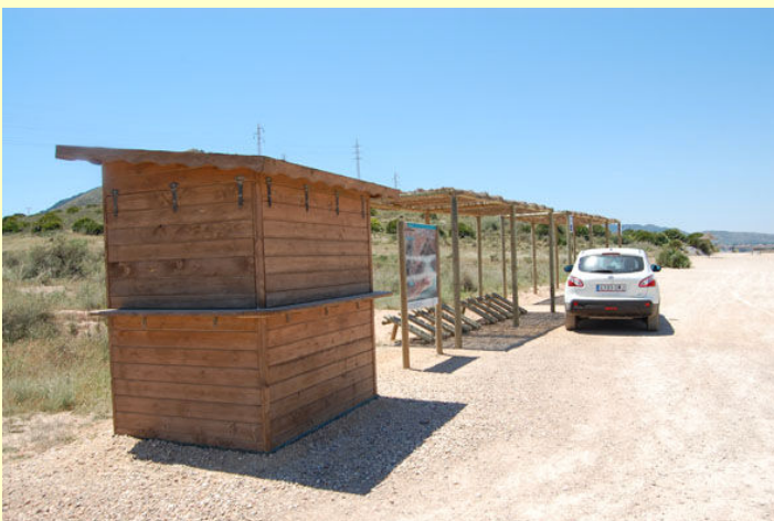
Estado actual de la zona de entrada
