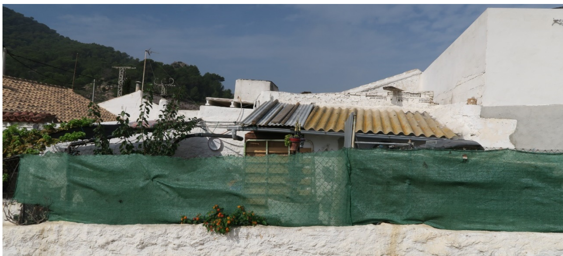
Placas de fibrocemento en construcción anexa de vivienda.
