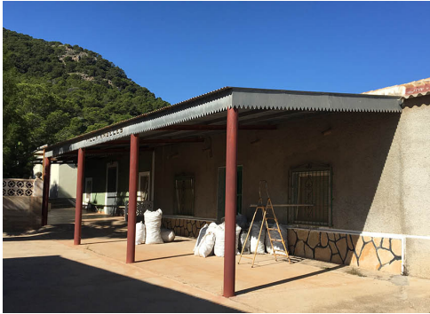
Porches con estructura soporte metálica y de hormigón
