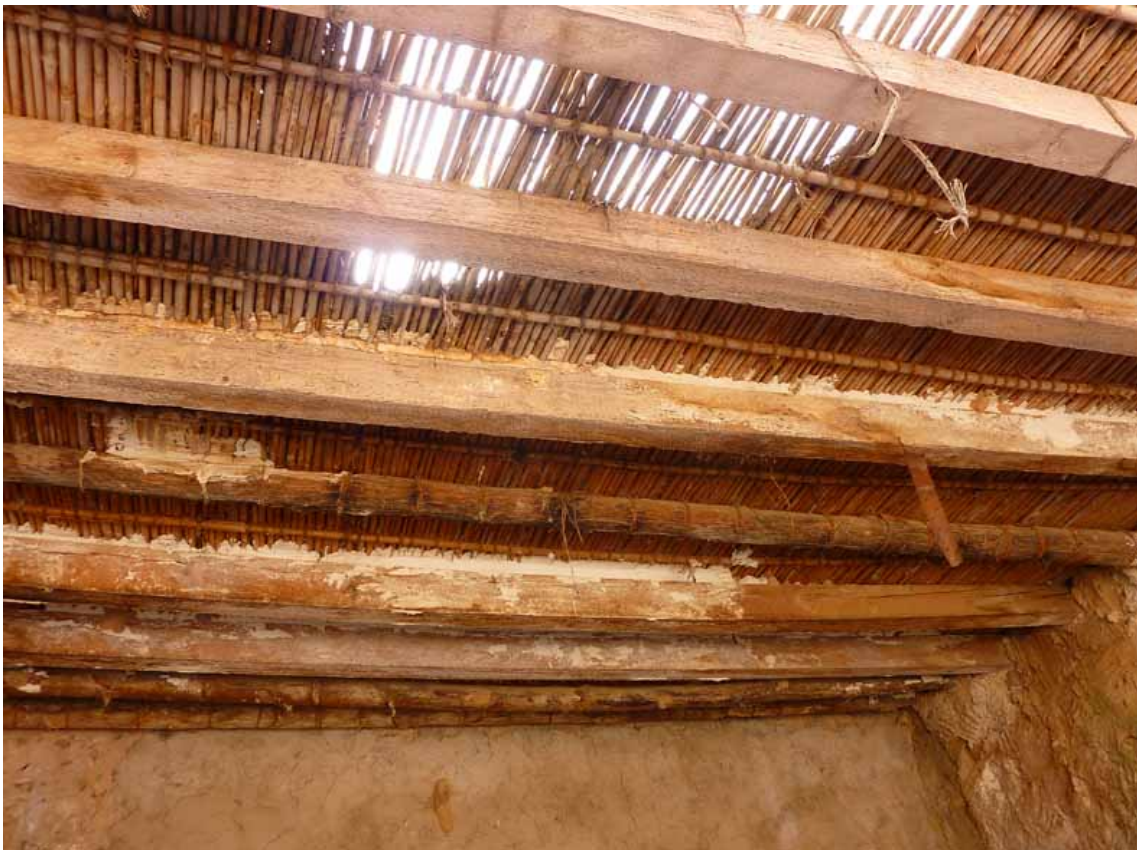
Forjado de colañas de madera, sobre ellas zarzos de cañas
