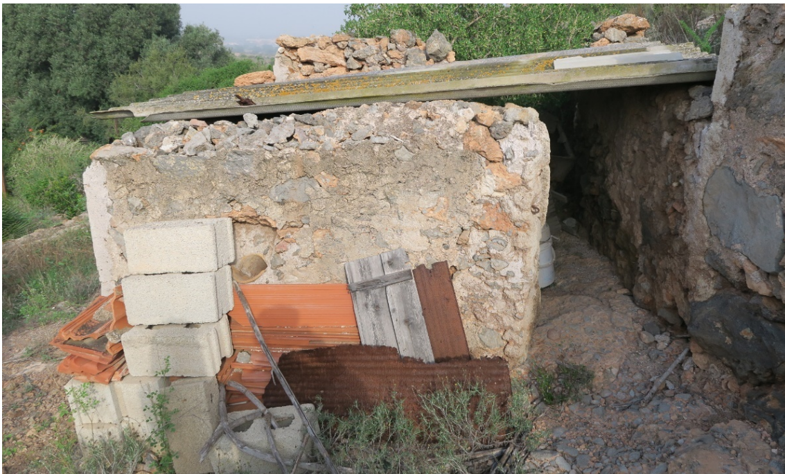
Estado Cochiquera vivienda J-04
