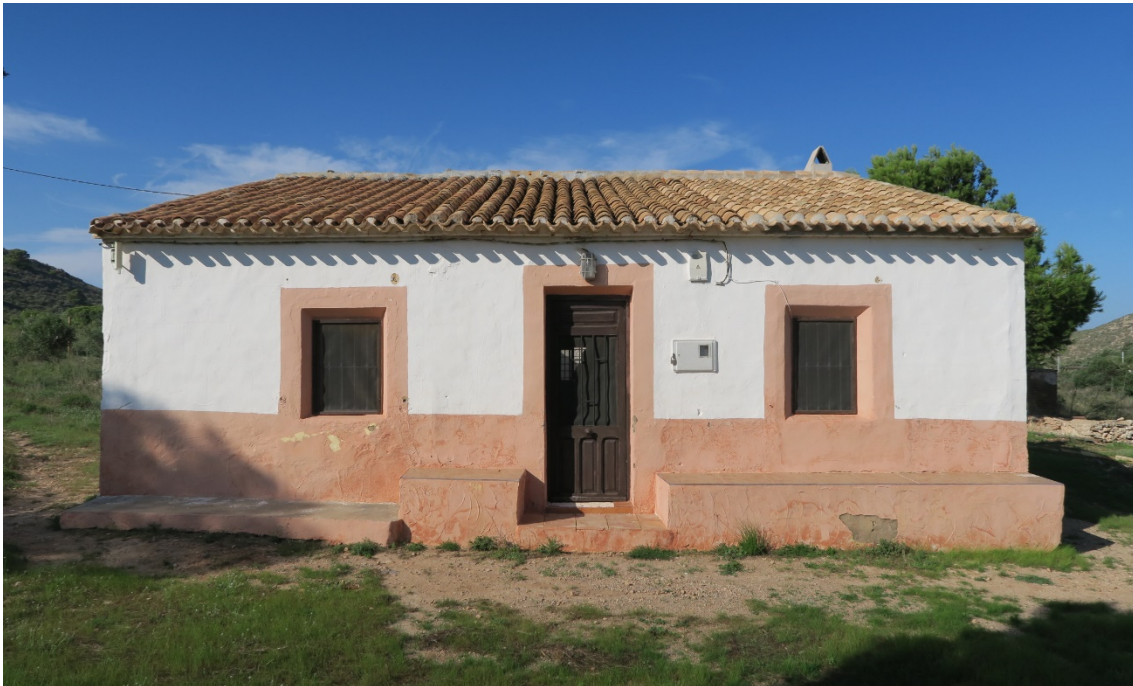
Casa en Cobaticas. Tipología cubierta inclinada
