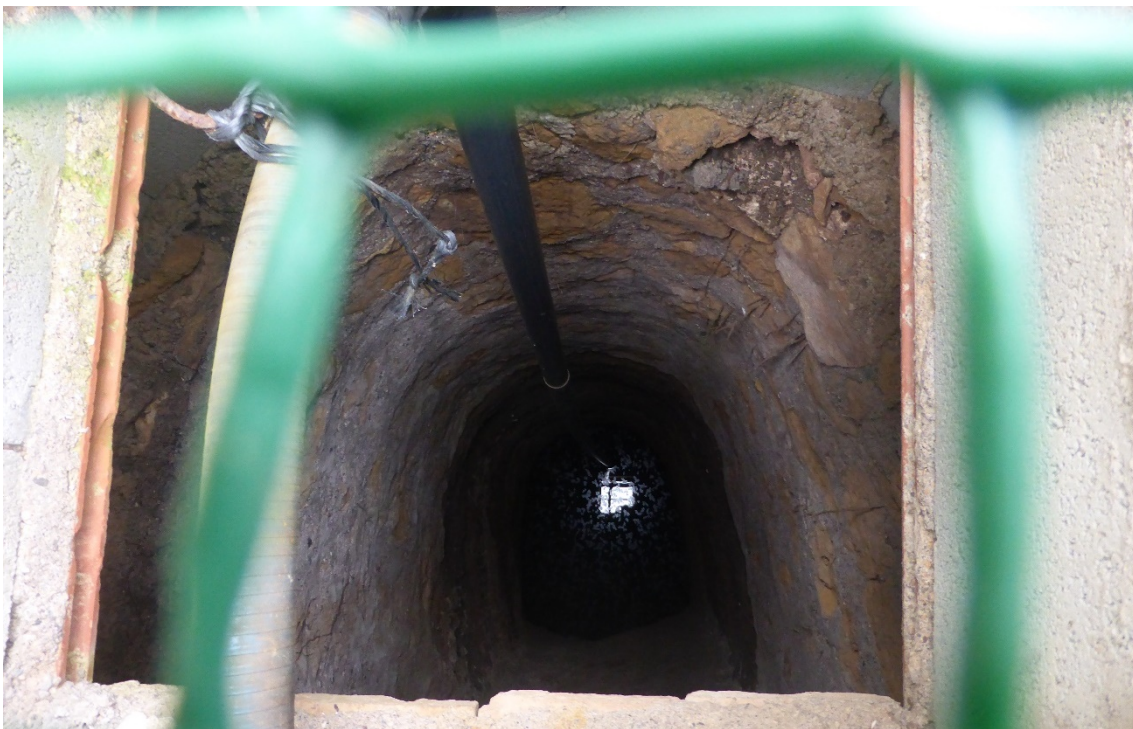
Pozo de la aceña de Los Perules
