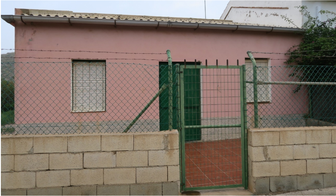
Vivienda J-01. Vallado de parcela con bloque de hormigón y malla metálica
