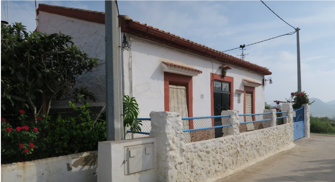
Tendido eléctrico rodeando la vivienda J-10
