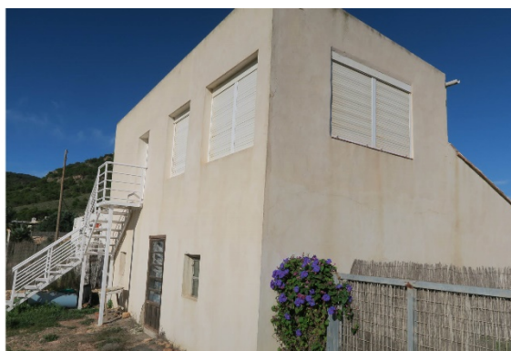
Construcciones C-10 y C-19
