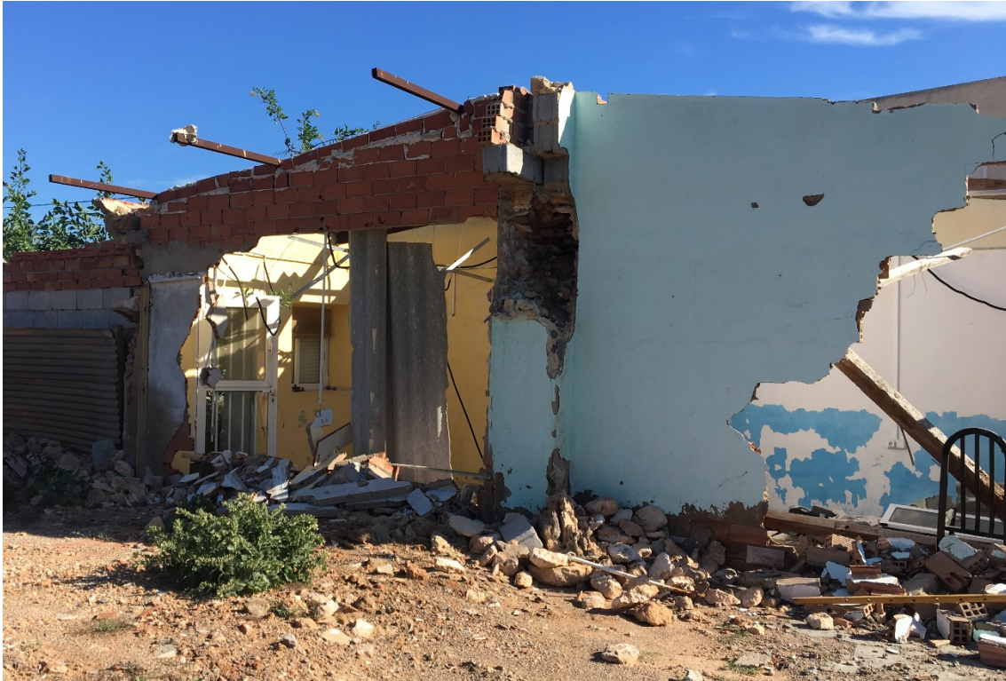
Estado actual construcción C-20
