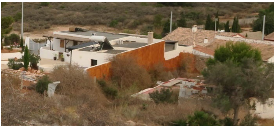
Vivienda J-08. Cerramiento medianero revestido con poliuretano proyectado.
