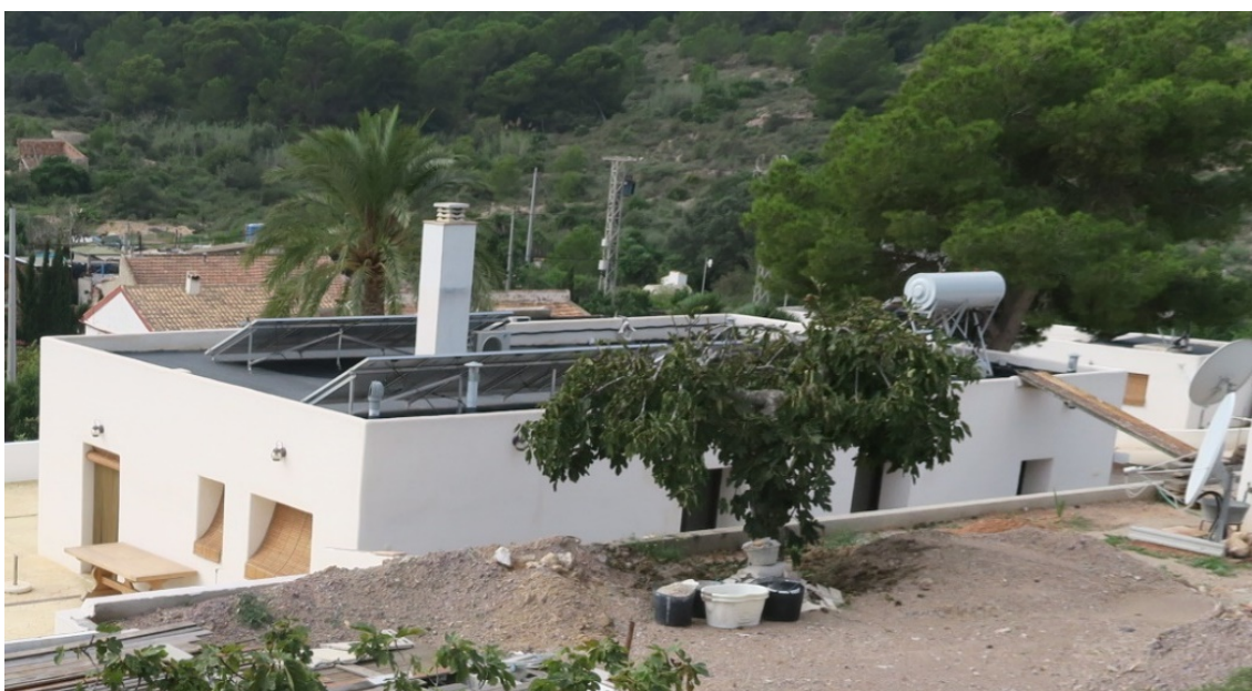
Vivienda J-12. Placas solares en cubierta
