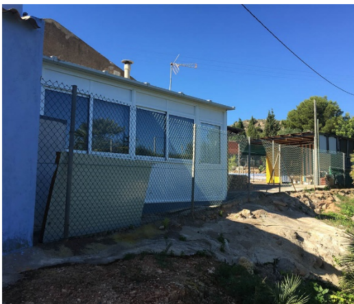
Construcciones con estructura metálicas y cerramientos de PVC
