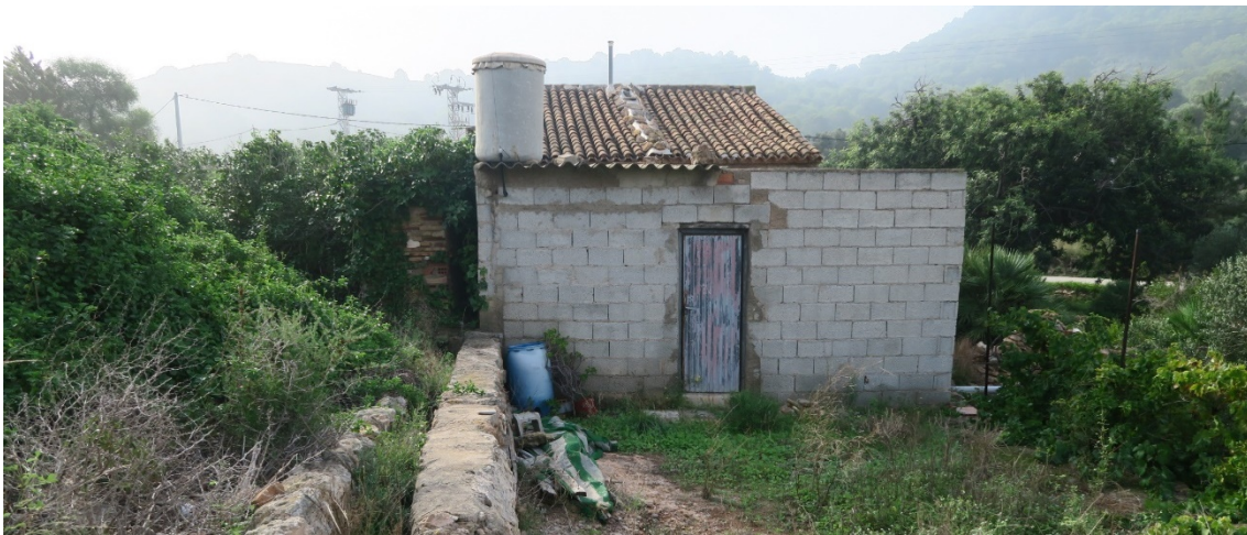
Vivienda J-05. Cerramiento de patio.
