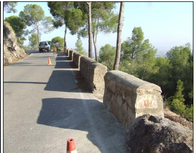
Delimitación zona de obras
