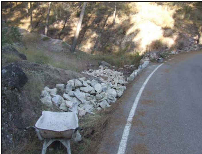
Inicio de la obras
